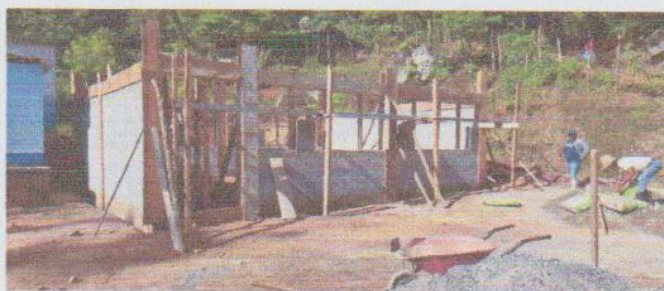
Foto 3: La construcción de la hilera de block ya está finalizada.
