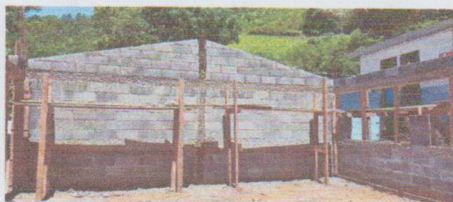
Foto 4: Las columnas de concreto están terminadas.
