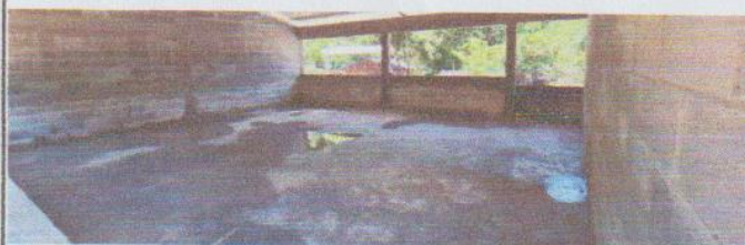
Foto 6: La torta de cemento está terminada en la aula tipo portico.
