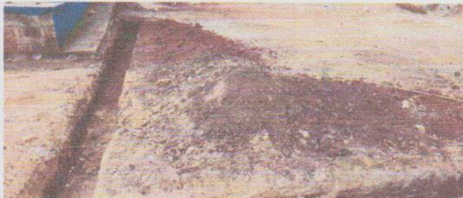
Foto1: Se empezó a zangear para la construcción del aula tipo portico.
