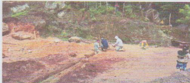
Foto 2: El zangear está finalizado para la construcción del aula tipo portico.
