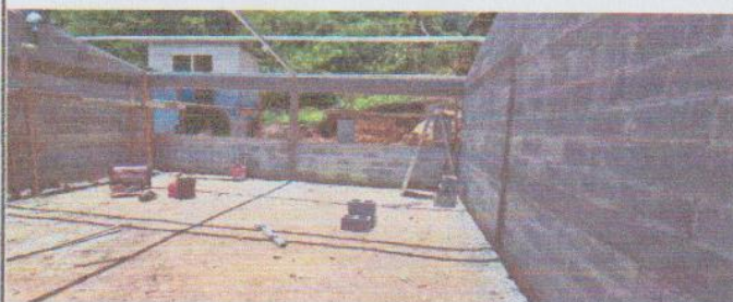
Foto 5: Instalación de constaneras para el techo del aula tipo portico.
